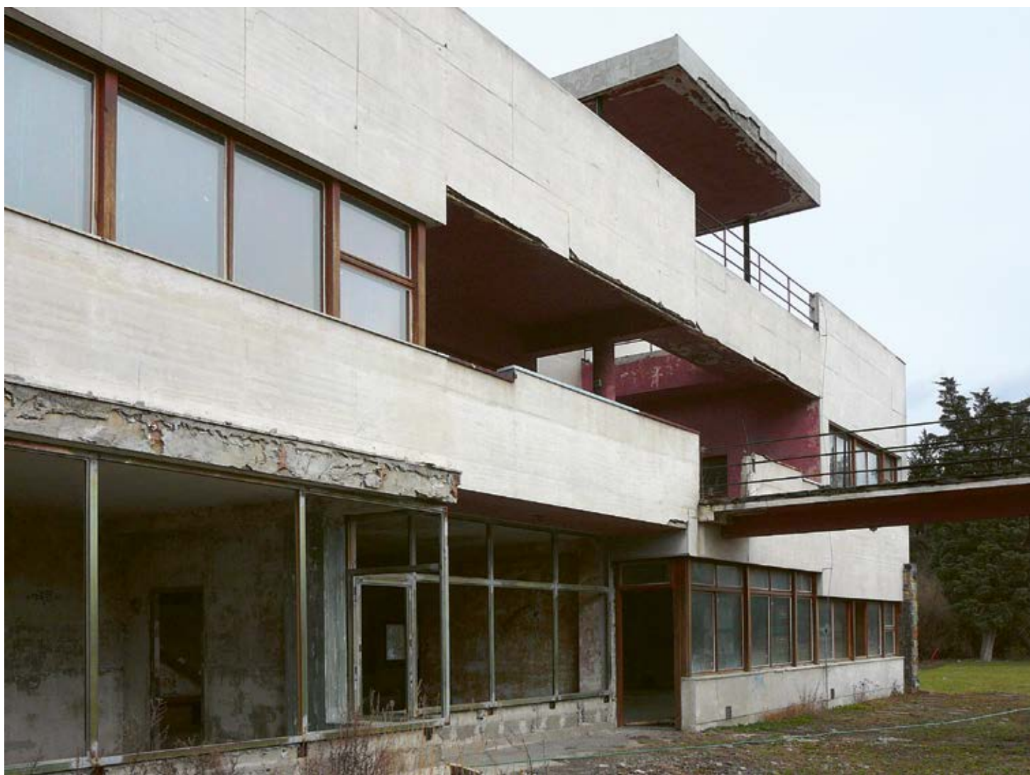
Jižní fasáda , 2008, archiv TAK
