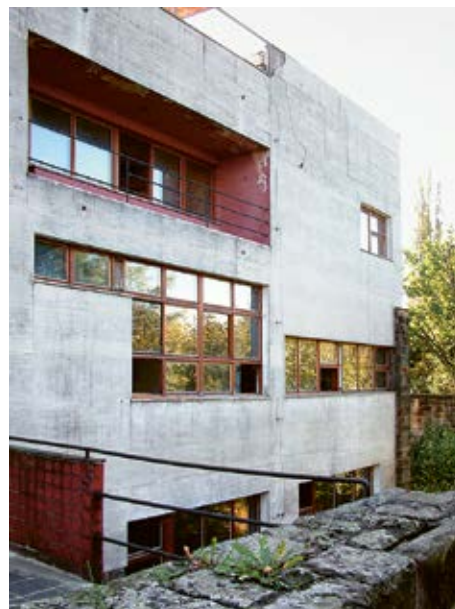
Severní fasáda , 2004, archiv TAK
